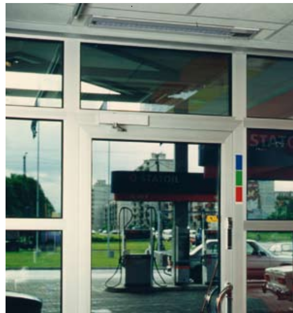
Установка в подвесной потолок
